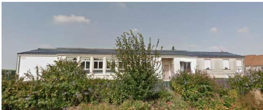
Centrale photovoltaïque de Bauquay (mairie/salle communale et logement)
