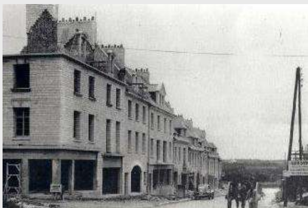
Ilot de la rue Pasteur en cours de reconstruction (Villers Bocage, 1949)
