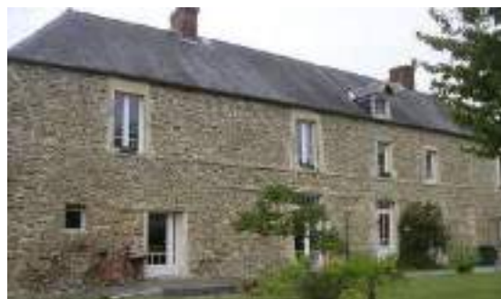
Exemple d'un bâti typique du territoire, en pierre schisteuse.
