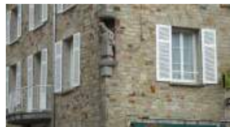
Zoom sur l'architecture de la reconstruction : moellons de pierre caractéristiques, fenêtres plus larges, balcon à rambarde.
