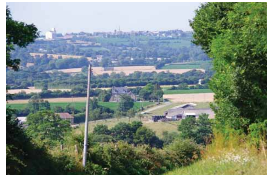
Fig. 57 Silo de Caumont et hangars qui ponctuent le paysage agricole en marquant la richesse de ses productions
