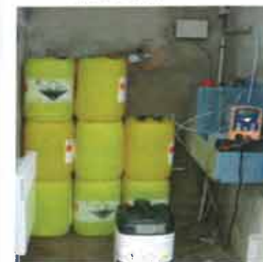
Système de chloration
