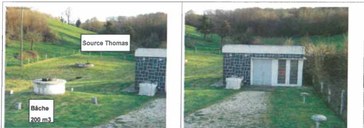
Photo 3 : Station de reprise d'Hamars
