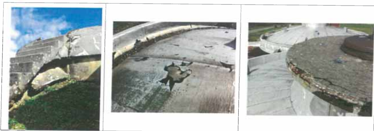
Figure 12 : Vues extérieures du réservoir
