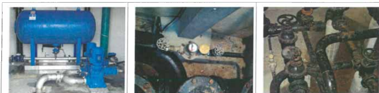
Figure 15 : Vues intérieures du réservoir
