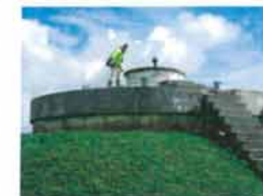
Vue extérieure d'une cuve
