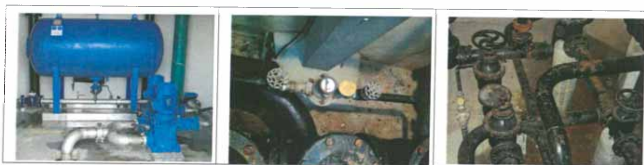
Figure 13 : Vues intérieures du réservoir
