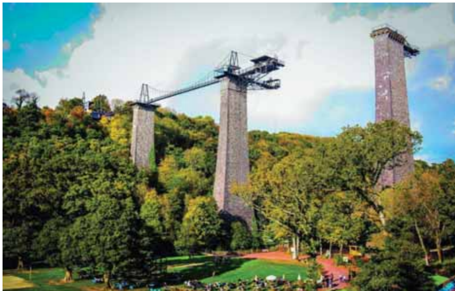
Fig. 29 Photographie du Viaduc de la Soulevre. Source : Camping Bois & Marais
