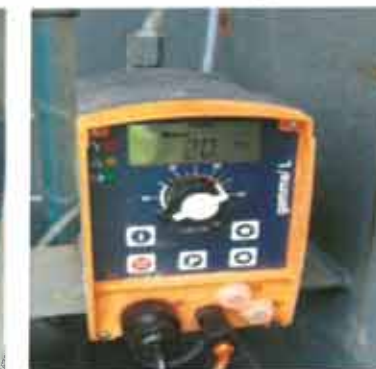
Système de chloration
