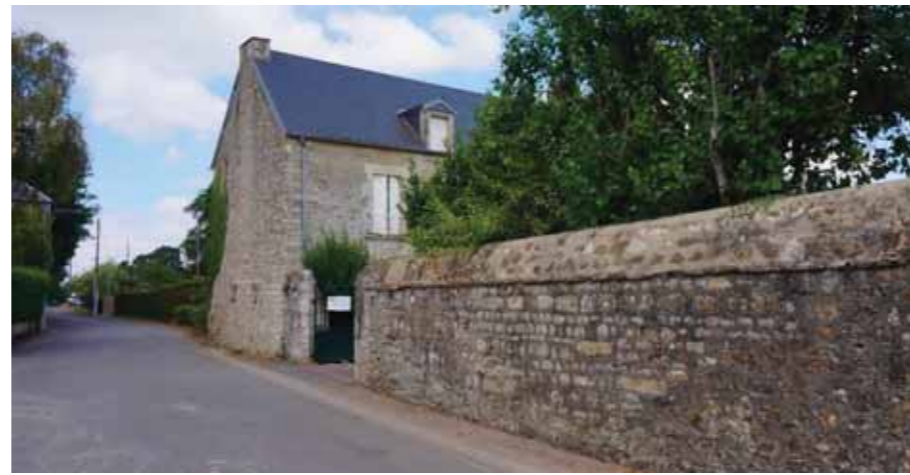
Fig. 73 : Mur et bâti calcaire à Monts-en-Bessin
