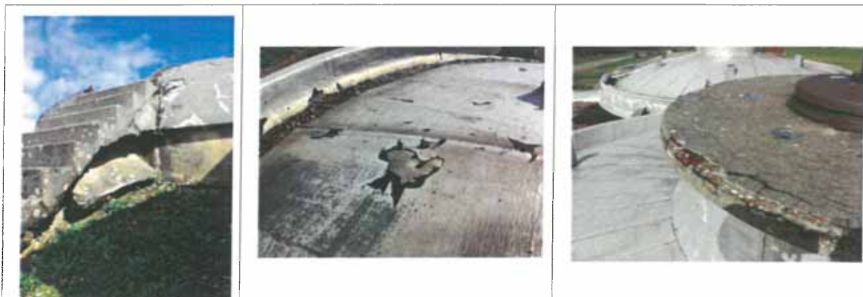
Figure 14 : Vues extérieures du réservoir
