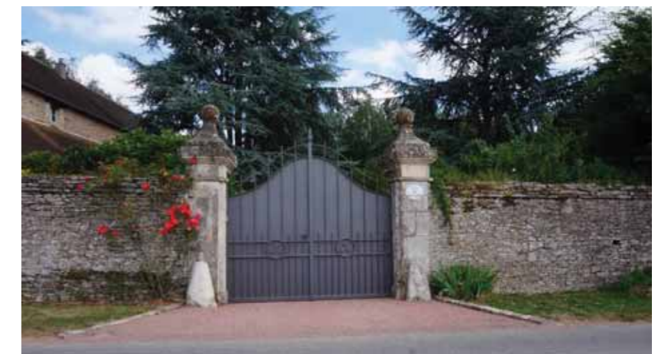
Fig. 154 : Portail et parc du Château de Quesnay
