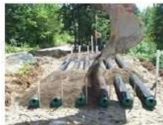
Exemple du dispositif de filière compacte à massif filtrant végétal
