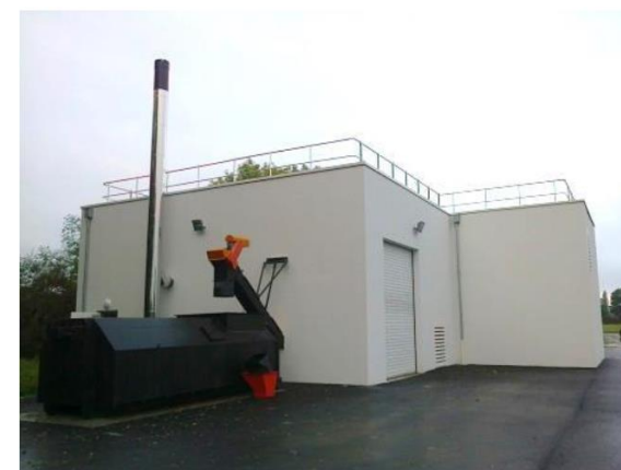
Chaufferie bois aux Monts d'Aunay (source : diagnostic du PCAET de PBI 2020)
