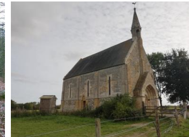
Vue sur la chapelle restaurée Saint-Clair – GAMA 2023
