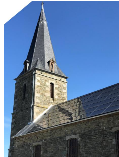
Panneaux solaires installées sur l'église de Brémoy (source : Réso, 2019)
