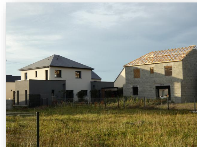
Maisons en construction rue des Aubépines aux Monts d'Aunay (source : Géostudio, 2023)
