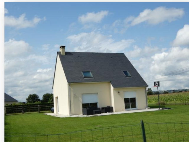
Maison individuelle à Cahagnes (source : Géostudio, 2023)
