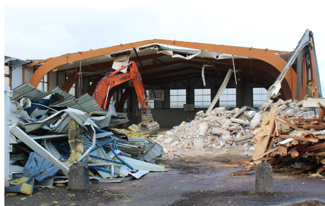
Travaux de démolition du gymnase du territoire de Les Monts d'Aunay
