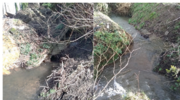
À gauche: buse présente en mauvais état avant travaux; À droite: vue après travaux de suppression de l'ouvrage
